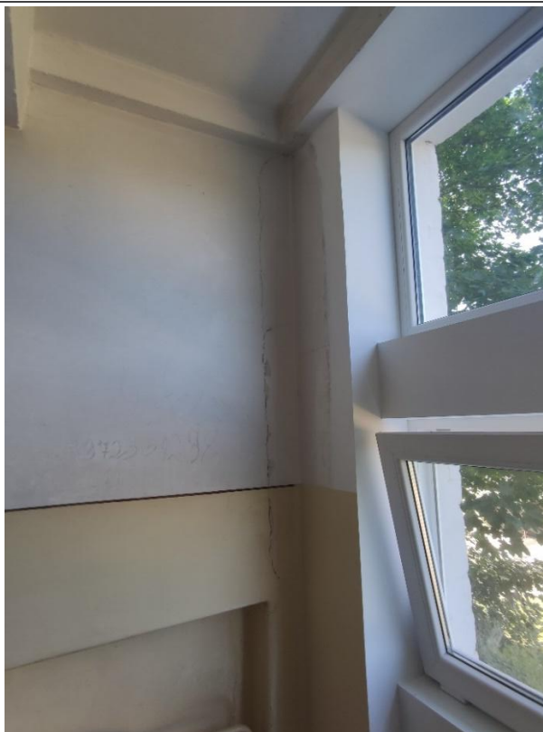
4.2.9. att. Fasādes shēma ar plaisām
