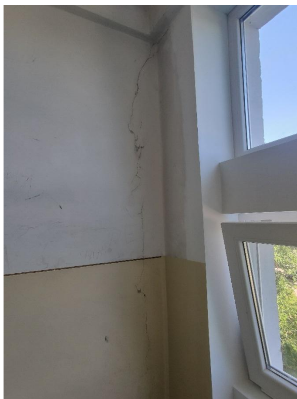
4.2.6. att. Fasādes shēma ar plaisām
