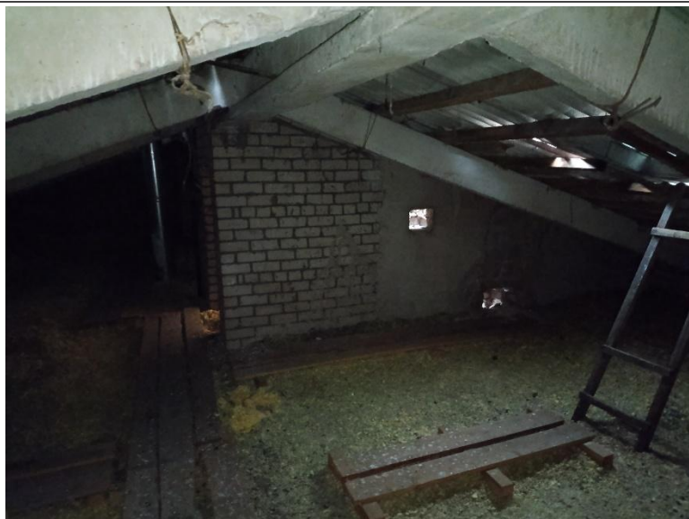
4.8.2. att. Caurumi jumta segumā
