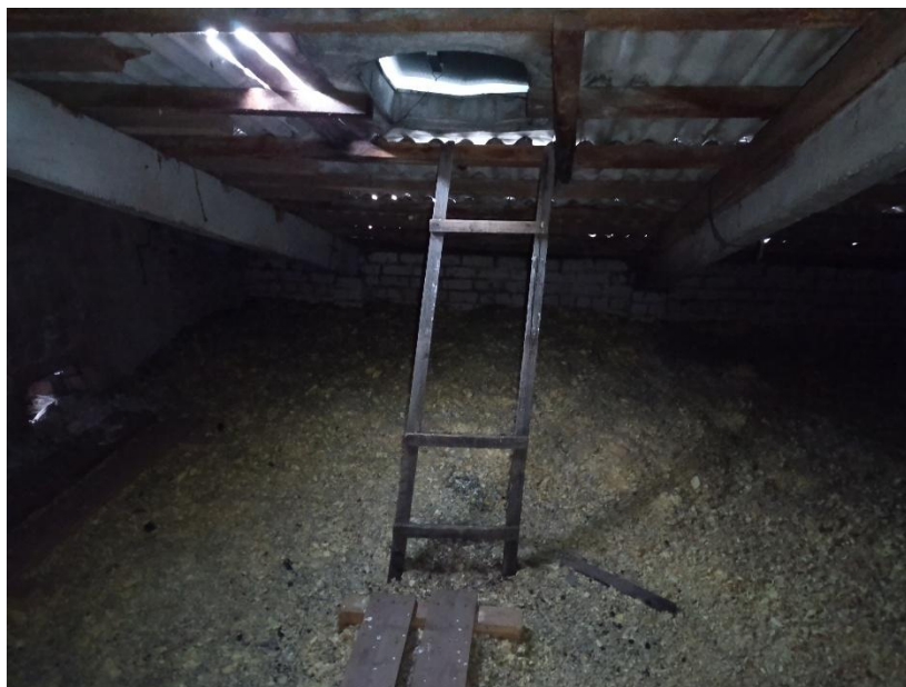
4.8.1. att. Caurumi jumta segumā
